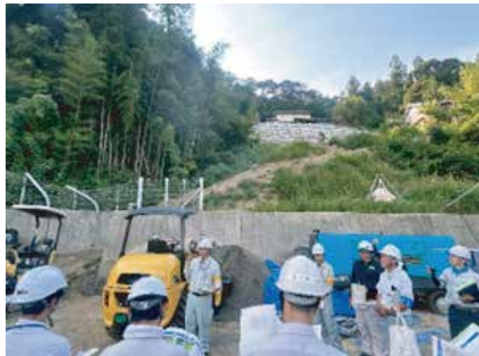
渡ヶ島禿石急傾斜地 現場説明状況
